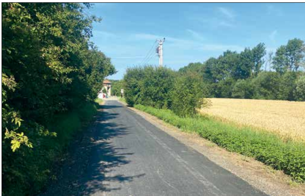
Oprava komunikace Kašparov-Vyškov
