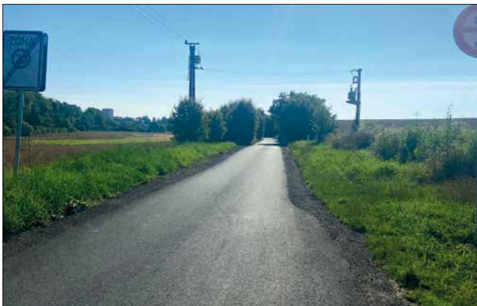
Oprava komunikace Kašparov-Vyškov
