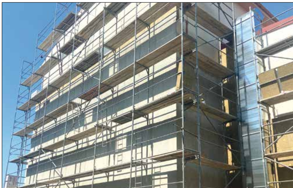
Zateplení a fasáda Kulturního domu
