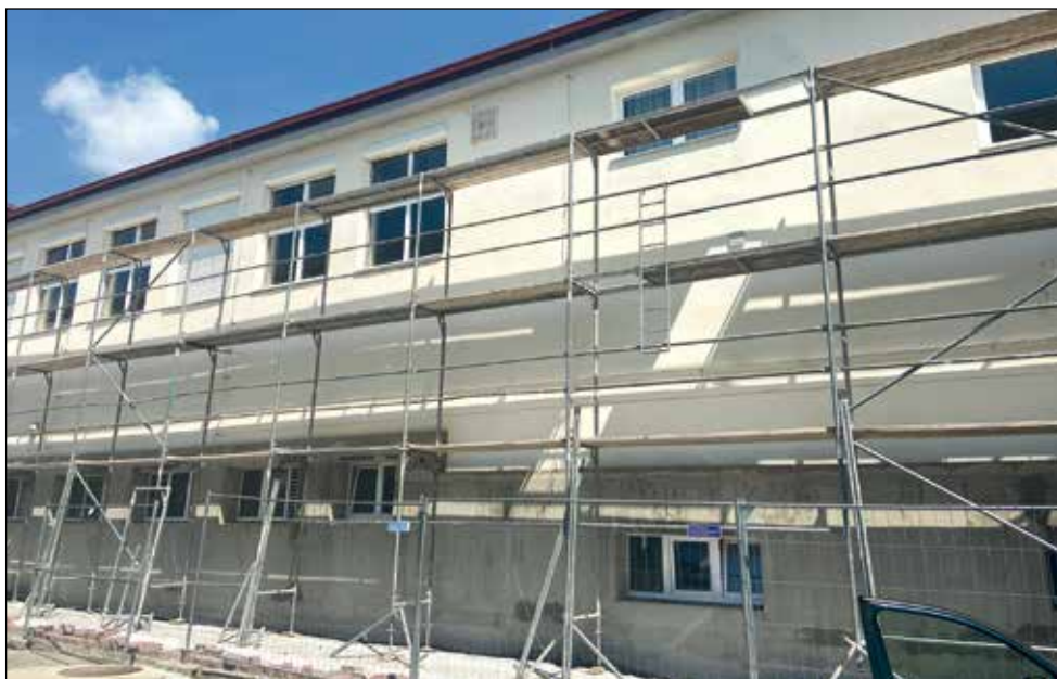
Zateplení a fasáda Kulturného domu
