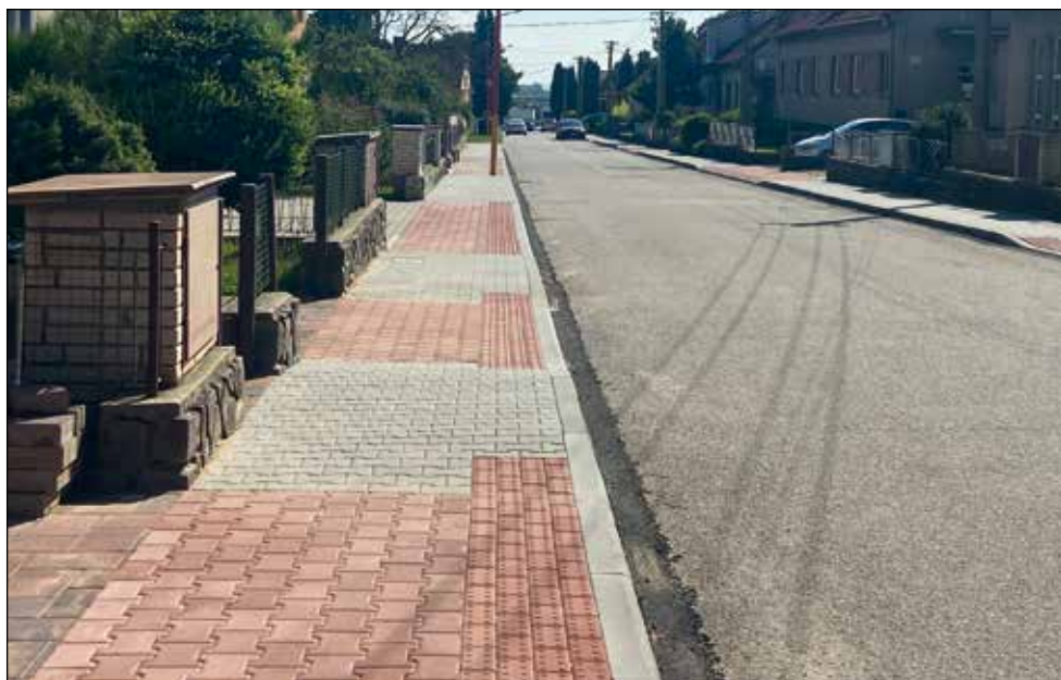
Oprava chodníků v místní části Příčný Dombas
