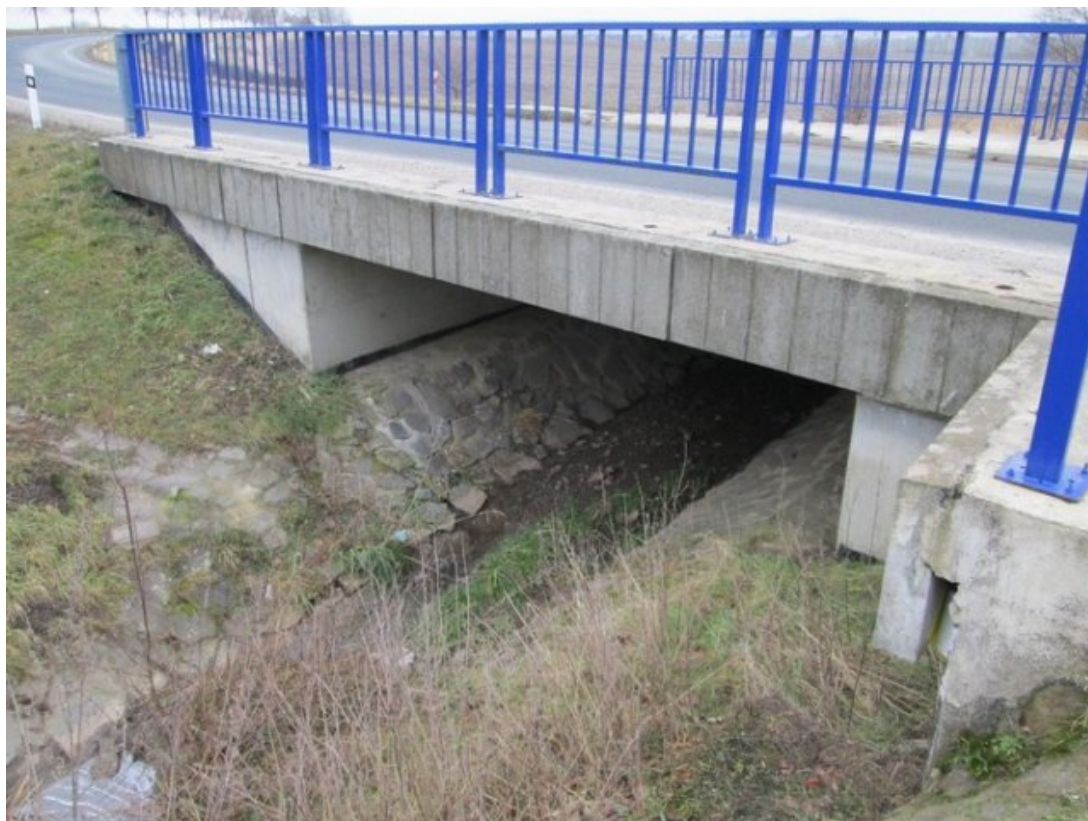
Obr. 7: Betonová mostní konstrukce přes silnici II/379
