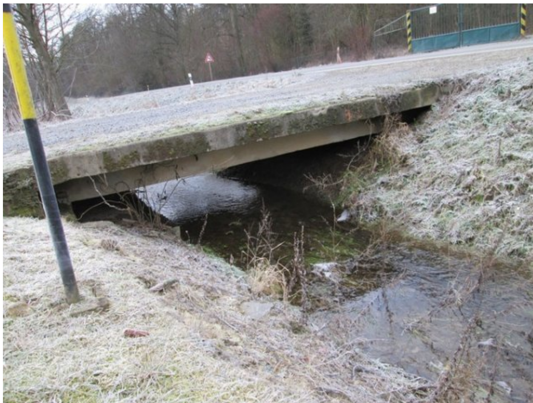
Obr. 6: Mostní konstrukce ze silnice II/379 k Prameništi Drnovice
