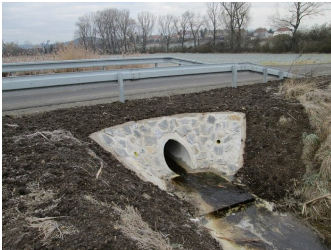
Obr. 5: Propustek pod zemědělským areálem
