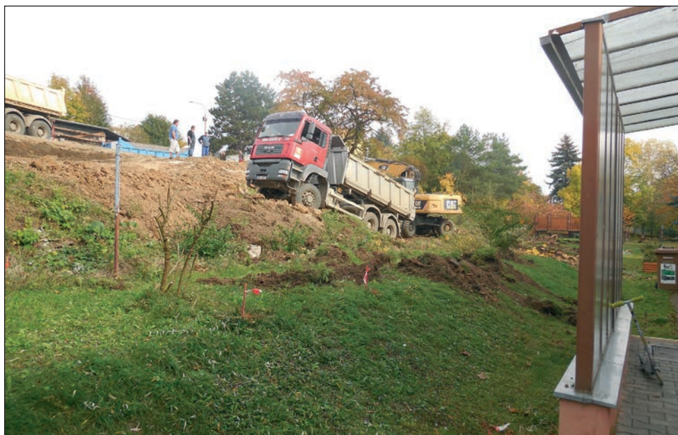
Říjen 2017 - zahájení přístavby MŠ
