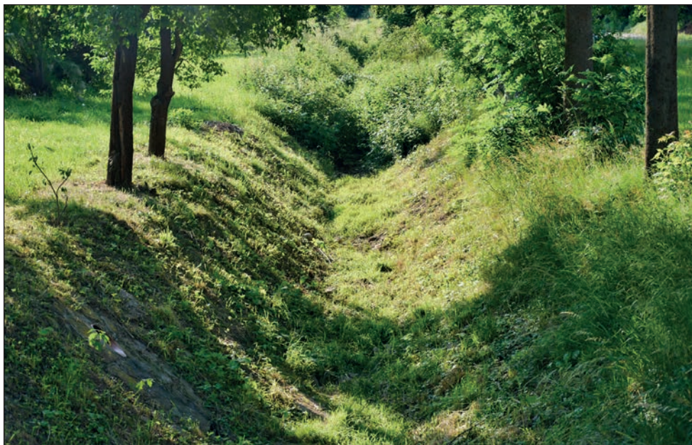
Prázdné dno potoka Drnůvka po předchozích vydatných průtržích
