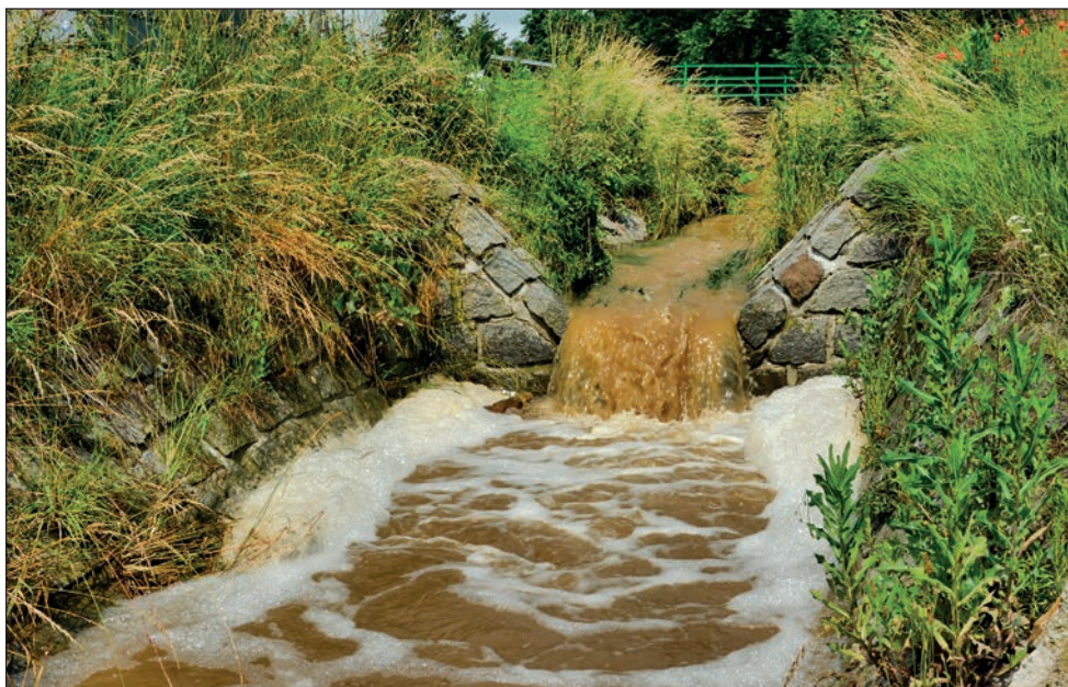
Jez s vývřištěm na toku potoka Drnůvka u ulice Žleb – stav dne 26. 6. 2020
