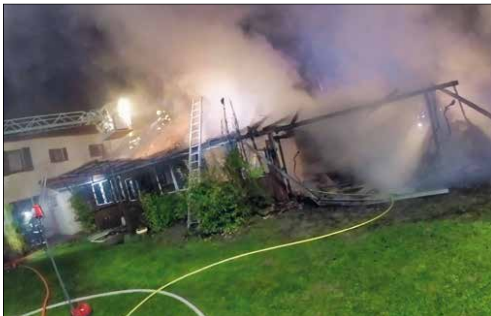
Požár hospodářského stavení v Rybníčku.
