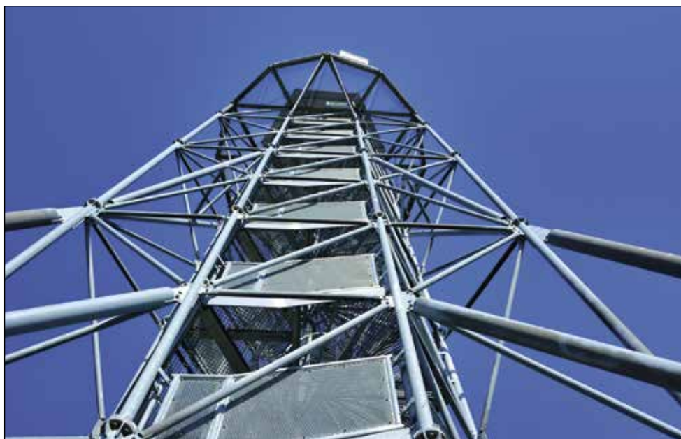
Foto č. 4: Kovová konstrukce rozhledny Chocholík
